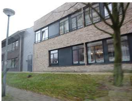
敷地の外側から外観(車窓より) Mapによると各居室が外側に向いているケースも多く、窓の扱いがどうなっているのが気になるところである
